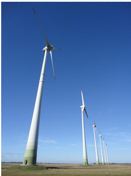
FIGURA 2 - AEROGERADORES DO PARQUE EÓLICO DE OSÓRIO.
