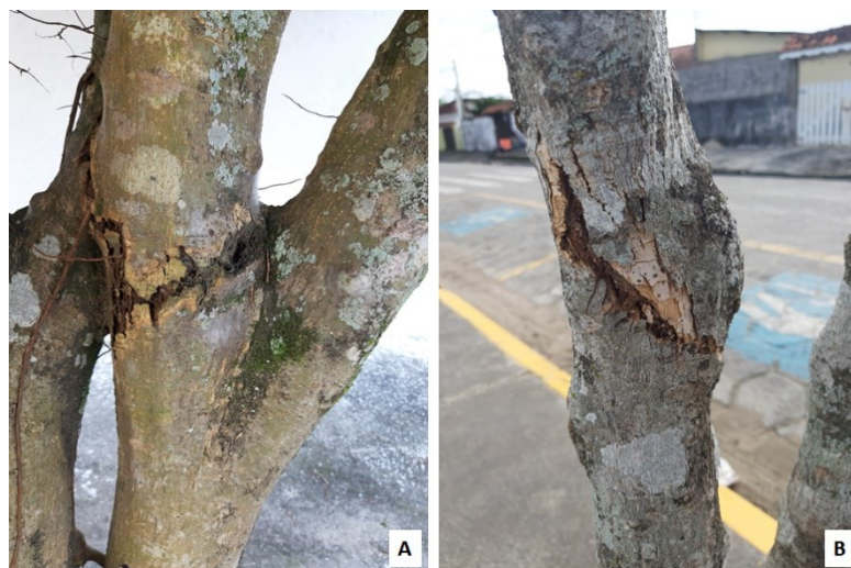
Figura 12. Presença de rachaduras em Ficus benjamina a) na bifurcação; b) ao longo do tronco Figure 12 Presence of cracks in Ficus benjamina a) at the fork; b) along the trunk
