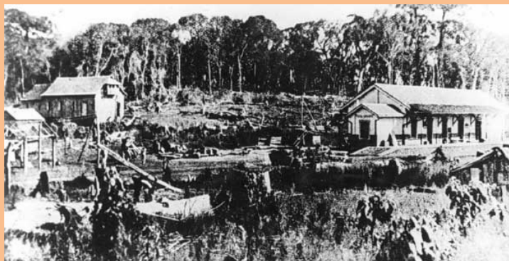
Figura 1. Estação Ferroviária de Paiol Grande em 1912, edificada entre os remanescentes florestais.
