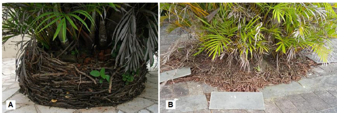
Figura 3. Palmeiras Areca-bambu com problemas no sistema radicial devido ao pouco espaço disponível A- Enovelamento; B- Danos ao pavimento
