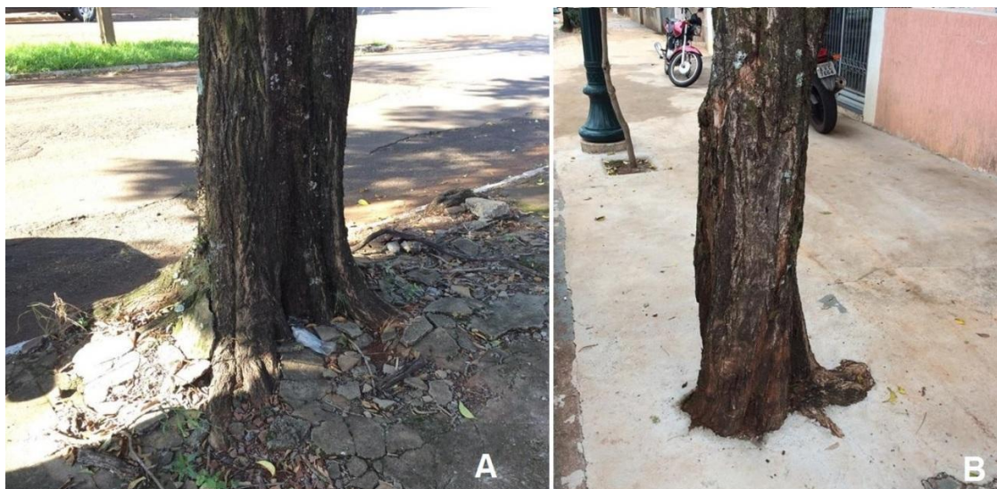
Figura 3. (A) quebra de calçada em função da inobservância as normas técnicas. (B) tronco em calçada reformada sem espaço para desenvolvimento, na cidade de Campo Mourão, PR
