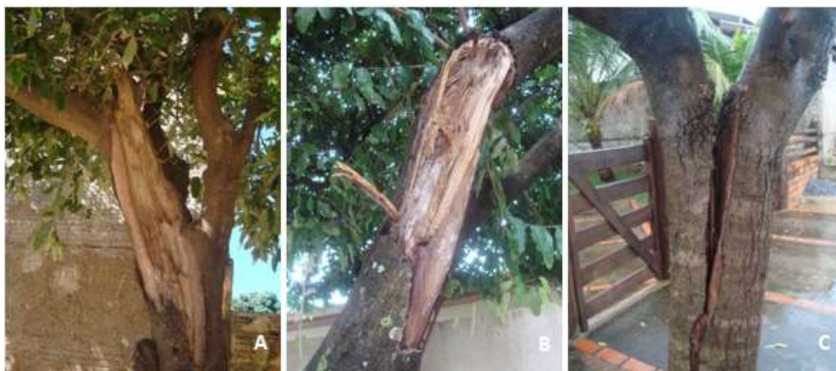
Figura 6. Danos físicos e defeitos estruturais encontrados em oitis na cidade de Bonito-MS. A, B – galhos quebrados com podridão associada e cancro pós lesão. C – Rachadura em fissura de galhos com bifurcação em “V”
