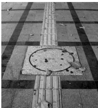
FIGURA 9 - BLOQUES DIRECCIONALES INTERRUPTIDOS POR TAPA DE ALCANTARILLA (SEOUL, KOREA)
