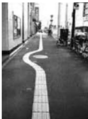
FIGURA 10 - BLOQUES REDIRECCIONADOS ALREDEDOR DE UNA TAPA DE ALCANTARILLA (HOKKAIDO, JAPÓN).
