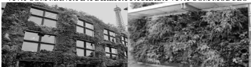
FIGURA 2: EXEMPLOS DE PAREDES VIVAS OU LIVING WALLS. À ESQUERDA, FACHADA VIVA COM MANTA E A DIREITA FACHADA VIVA COM MÓDULO
