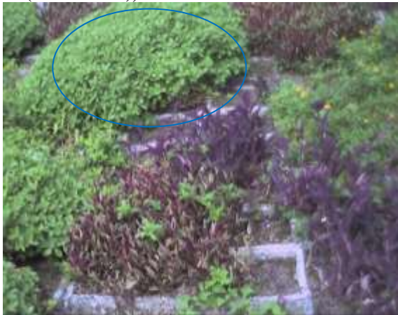
FIGURA 9: IMAGEM DA TECNOLOGIA TELHADO VIVO EXECUTADA NO PRÉDIO 1 (REITORIA), CAMPUS CENTRAL PUCRS
