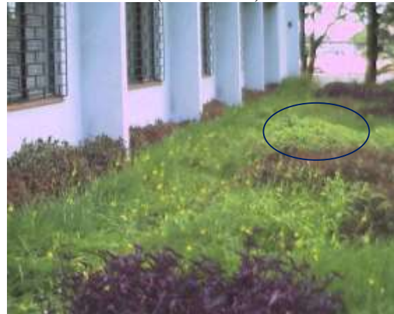
FIGURA 7: IMAGEM DA TECNOLOGIA TELHADO VIVO EXECUTADA NO PRÉDIO 1 (REITORIA)
