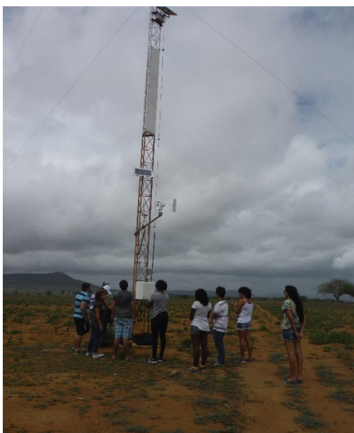
Figura 02: Torre anemométrica instalada no município de Craíbas/AL. Fonte: Autor, 2016
