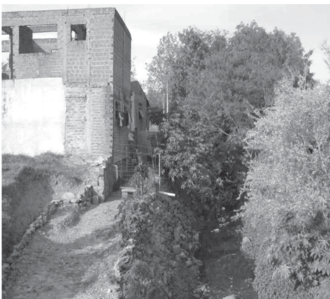
FIGURA 8 - PROTEÇÃO DAS MARGENS DA SANGA DA ALDEIA COM PEDRAS SOLTAS
