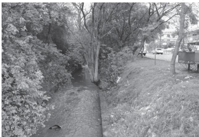
FIGURA 4 - TRECHO RETIFICADO DO ARROIO CADENA COM PROTEÇÃO DAS MARGENS COM MURO DE CONCRETO E VEGETAÇÃO
