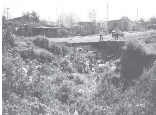
FIGURA 10 - PROCESSO DE VOÇOROCAMENTO EM NASCENTE DO ARROIO PASSO DA AREIA.
