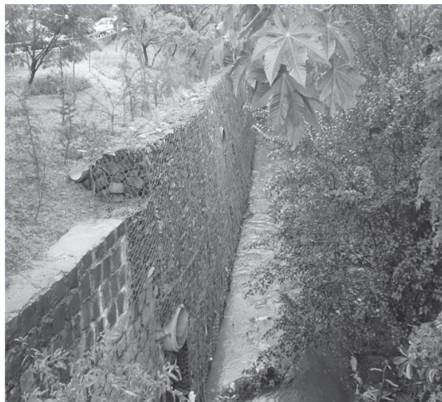
FIGURA 9 - PROTEÇÃO DAS MARGENS DO ARROIO CANCELA COM MURO DE ARRIMO
