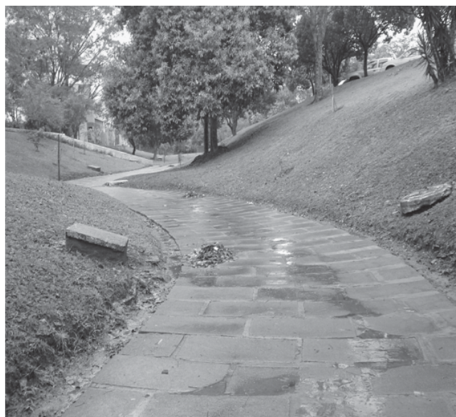
FIGURA 6 - CANALIZAÇÃO FECHADA DO ARROIO ITAIMBÉ. NA ÁREA LOCALIZADA JUNTO AO PARQUE SEU CANAL FOI TRANSFORMADO EM PASSEIO PÚBLICO.
