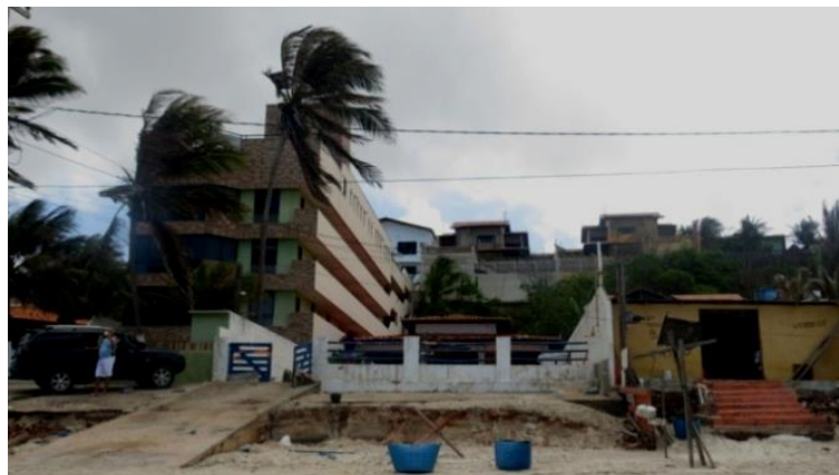
Figura 5 - Residências construídas em antepraia – Praia do Meio. Fonte: Dados da pesquisa/Janeiro de 2014
