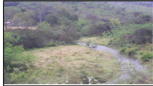
Figura 9A. Pinguela, rio Mato Preto, Comunidade Mato Preto, Cerro Azul/PR. Trânsito entre residências e estrada. Fonte: Pesquisa de campo (2006).
