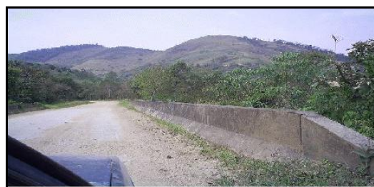
Figura 7. Ponte de Alvenaria, rio Canha, Cerro Azul/PR. Fonte: Pesquisa de campo (2006).
