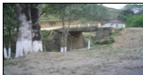
Figura 5. Ponte de alvenaria, rio João Gordo, Comunidade do Mato Preto, Cerro Azul/PR. Fonte: Pesquisa de campo (2006).
