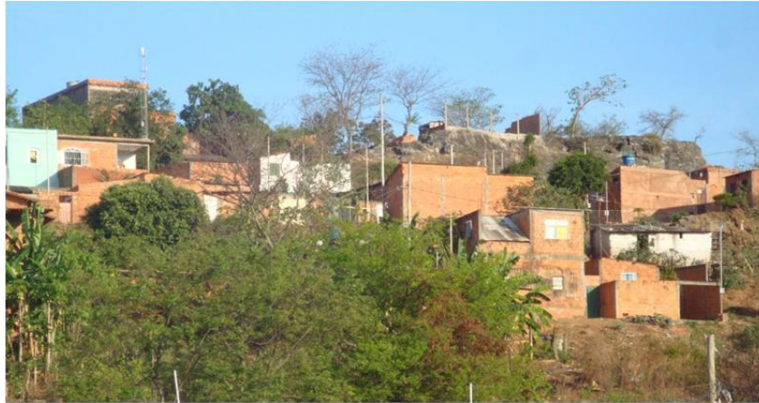
Figura 03 - Construções na encosta do Morro do Frade, na Vila São Francisco de Assis
