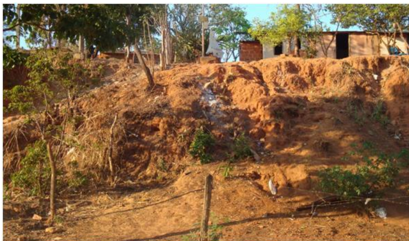
Figura 02 - Ocupação de terreno próximo a talude na Vila Atlântica Autor: Leite, 2010.
