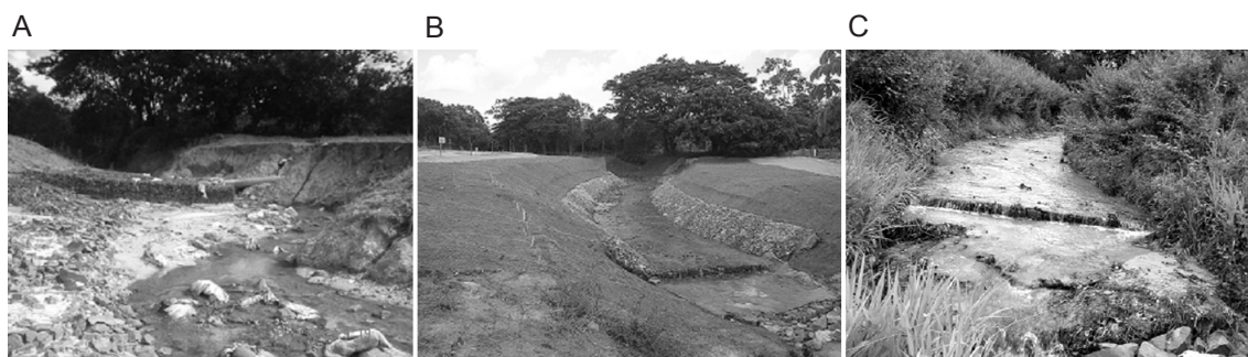
FIGURA 7 - FASES DA IMPLANTAÇÃO DA BIOENGENHARIA NAS MARGENS DO RIO PARAMOPAMA : A) MARGEM ERODIDA; B) IMPLANTAÇÃO DO GEOTÊXTIL E COLCHÃO-RENO; C) MARGEM REVEGETADA (PERÍODO DE JANEIRO/2007 A MARÇO/2008)
