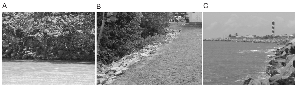
FIGURA 4 - USO DO ENROCAMENTO: A) TALUDE ESTABILIZADO NO PERÍMETRO IRRIGADO CONTIGUIBA-PINDOBA, EM PROPRIÁ; B) MARGEM DO RIO SERGIPE, EM ARACAJU; C) BAIRRO COROA DO MEIO, EM ARACAJU (MARÇO/2007)
