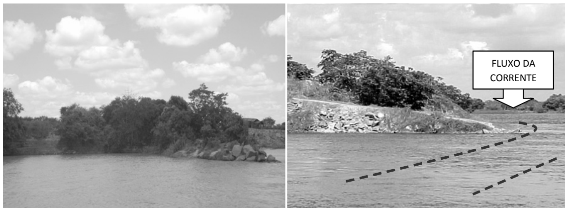
FIGURA 3 - ESPIGÕES CONSTRUÍDOS NO PERÍMETRO IRRIGADO COTINGUIBA-PINDOBA EM 1985 E 2001, RESPECTIVAMENTE (MARÇO/2007)
