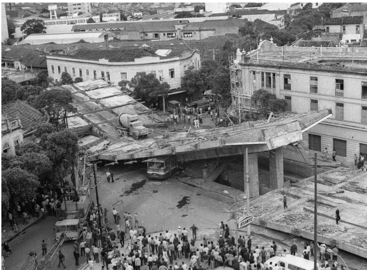
Imagem 2 – Fotografia da queda do módulo do viaduto Paulo de Frontin, no Rio de Janeiro
