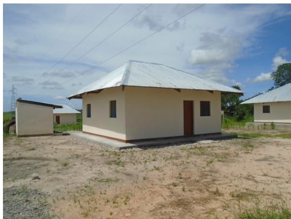
FIGURA 2 – Exposição a riscos das casas de reassentamento em Mucaia 1, construídas por baixo da linha de alta tensão.
