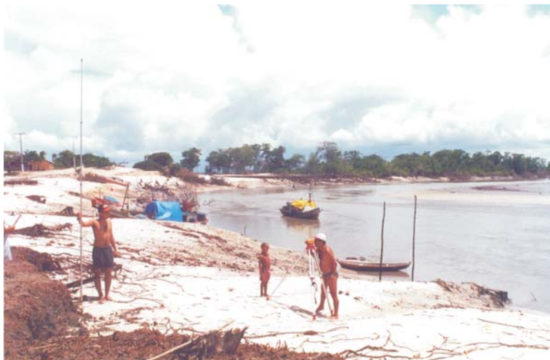
B) EROSÃO NAS MARGENS DO FURO DA ESTIVA
