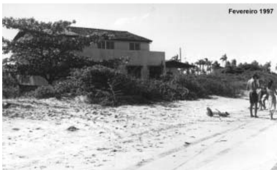
FIGURA 8A - EROSÃO COSTEIRA ACELERADA NA COSTA DO MUNICÍPIO DE ITAPOÁ, RELACIONADA ÀS DRAGAGENS DO CANAL DE ACESSO AO PORTO DE SÃO FRANCISCO DO SUL. AS FOTOGRAFIAS SÃO DO MESMO LOCAL, PORÉM TIRADAS DE DIFERENTES ÂNGULOS. NOTAR A DESTRUIÇÃO COMPLETA DAS CONSTRUÇÕES ENTRE 1997 E 2002. INTENSE BEACH EROSION AT ITAPOÁ COAST RELATED TO DREDGING OF THE ACCESS CHANNEL TO SÃO FRANCISCO HARBOR. PHOTOGRAPHS FROM THE SAME LOCATION WERE TAKEN AT DIFFERENT ANGLES. NOTE THE TOTAL DESTRUCTION OF MAN-MADE STRUCTURES BETWEEN 1997 AND 2002
