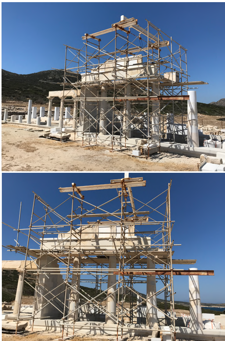
Figuras 25, 26, 27, 28, 29, 30 e 31 – Fotos da restauração do edifício A em Despótico.
