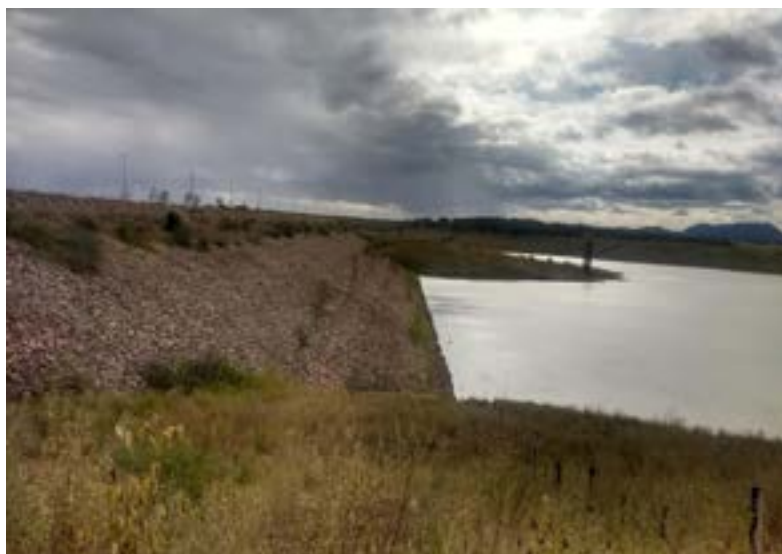
Figura 10. Situação do açude Poço da Cruz em julho de 2016 a montante da comunidade Poço da Cruz, município de Ibimirim – PE
