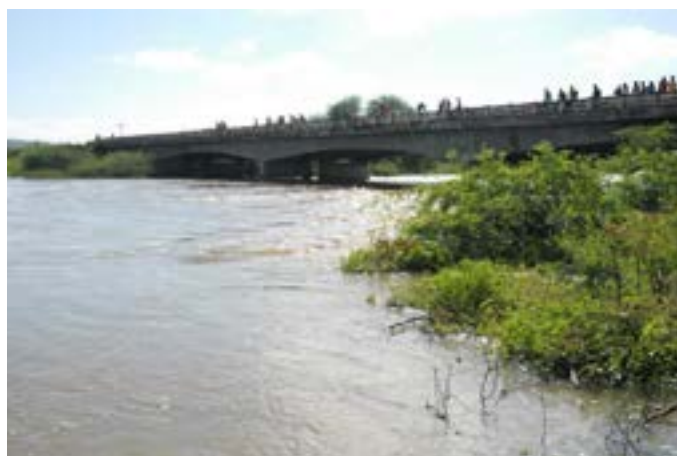
Figura 5: Registro da enchente sobre a ponte do rio moxotó, em Ibimirim – PE, no ano de 2004
