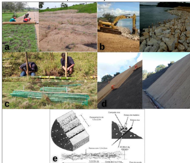
Figura 5: Exemplos de técnicas de bioengenharia: a) biomantas; b) enrocamento; c) paliçadas; d) geocélulas; e) esquema de caniçadas vivas.
