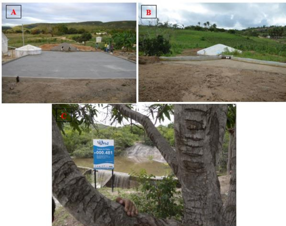
Figura 02: A – Cisterna calçadão; B – Tanque de pedra ou Caldeirão
