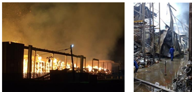
Figura 2: Incêndios em Paranaguá. Esquerda: Armazém de algodão e bobina de papel. Direita: fábrica de embalagens.
