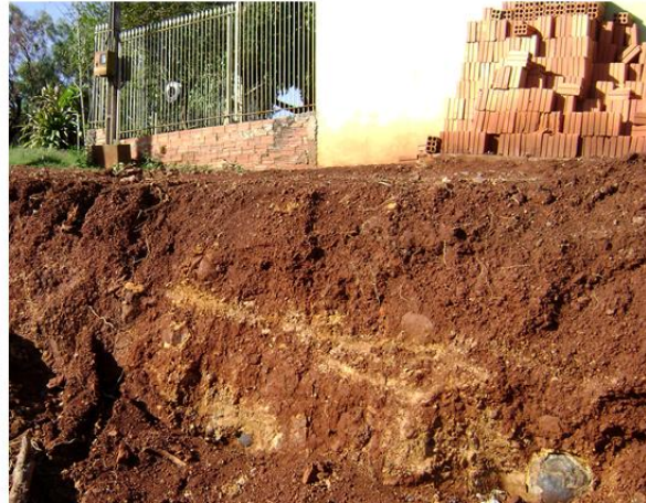
Foto 04. Setor de forte fragilidade. Presença de Neossolos localizados nos setores de baixa vertente do Bairro Marechal. Final da Rua São Lucas. Fonte: acervo do autor (agosto de 2011).
