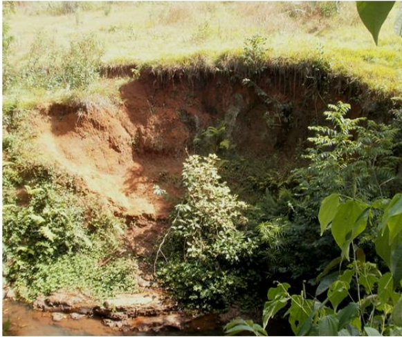
Foto 05. Setor de média a forte fragilidade. Processo erosivo encontrado na margem direita do Córrego Matilde Cuê, final da Rua Mato Grosso, Bairro São Lucas. Fonte: acervo do autor (agosto de 2011).
