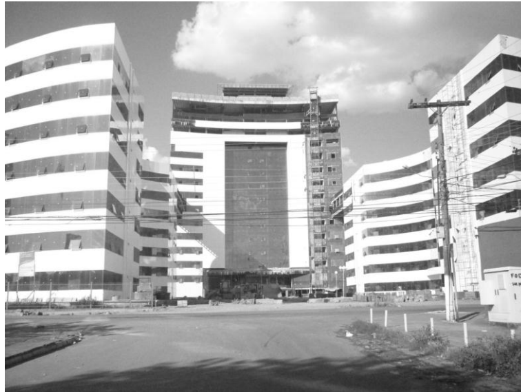
Figura 5 – Centro Administrativo do Governo do Estado de Rondônia, em Porto Velho
