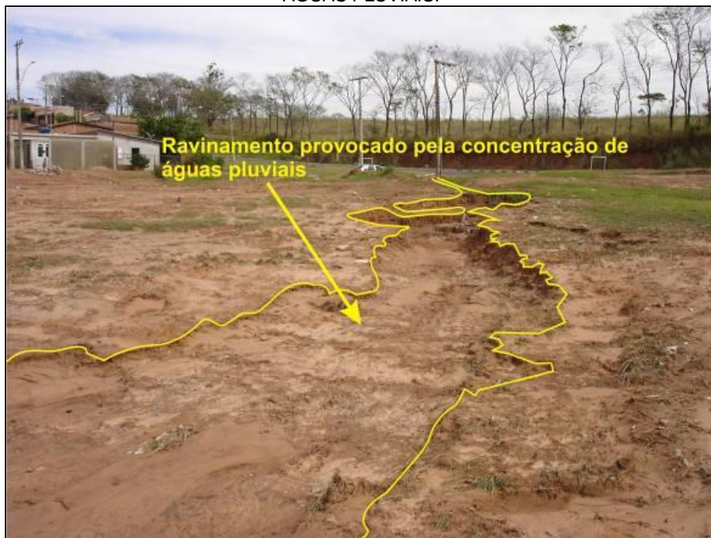
FOTO 01. PROCESSO DE RAVINAMENTO PROVOCADO PELA GRANDE CONCENTRAÇÃO DE ÁGUAS PLUVIAIS.
