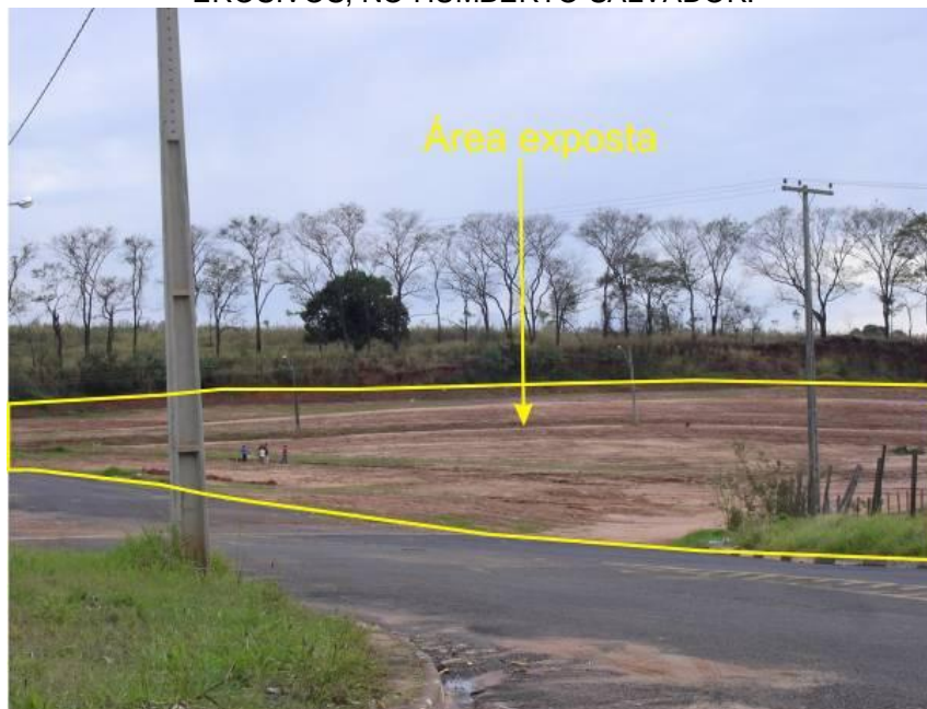
FOTO 07. ÁREA TOTALMENTE PROPICIA AO DESENVOLVIMENTO DE PROCESSOS EROSIVOS, NO HUMBERTO SALVADOR.
