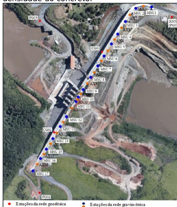
Figura 5 - Localização das estações gravimétricas na barragem da UHE de Mauá.
