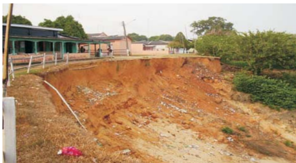
Figura 4 – Vista parcial das “terras caídas” em Calama – setembro de 2010. Pode ser observado na parte superior, um ribeirão passando na parte da calçada que resistiu ao escorregamento, já em uma real situação de risco. Pode ser observado também um cano de água parcialmente exposto e uma cerca improvisada para dar segurança aos pedestres, principalmente crianças. Fonte: Arquivo do Autor
