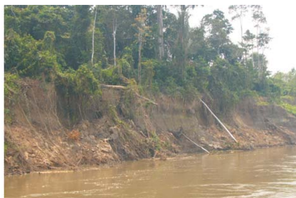
Figura 1 – Desmoronamentos com o comprometimento da vegetação marginal. Fonte: arquivo do autor
