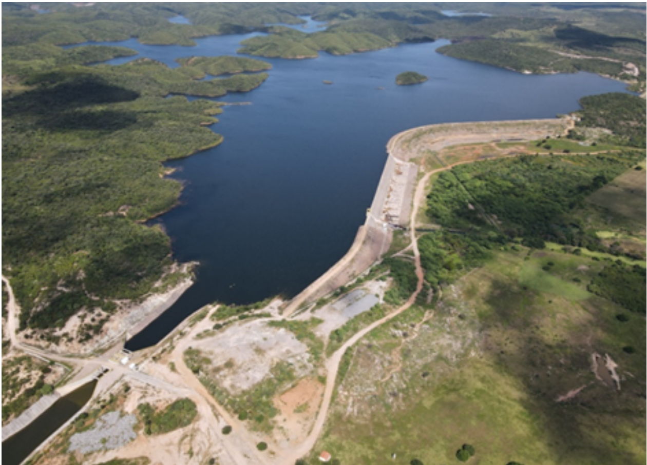
Figura 4. Vista Aérea da Barragem Porcos. Fonte: MIDR – Projeto de As Built (2022).
