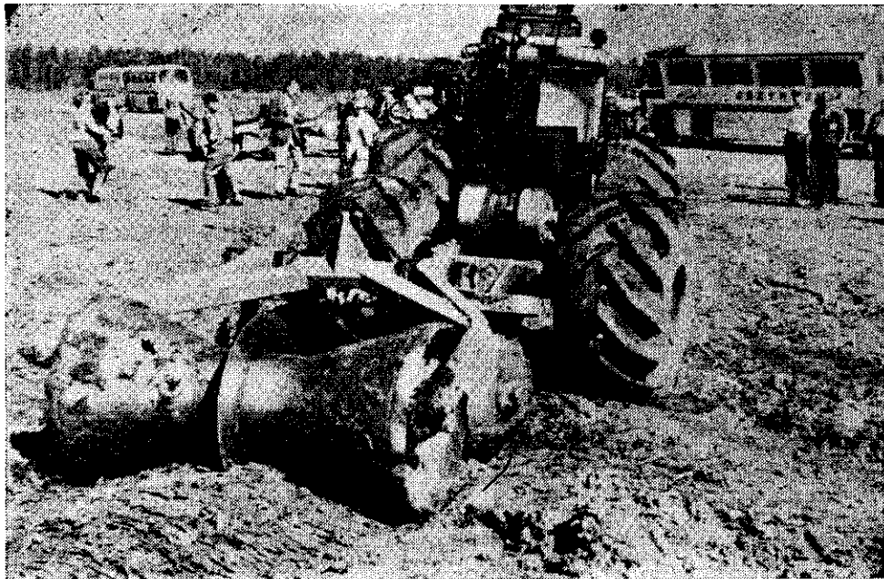
Nos Estados Unidos o Pinus elliottii comumente é plantado em áreas muito húmidas. Camalhões feitos com esse implemento proporcionam às mudas excelentes condições para seu estabelecimento.
