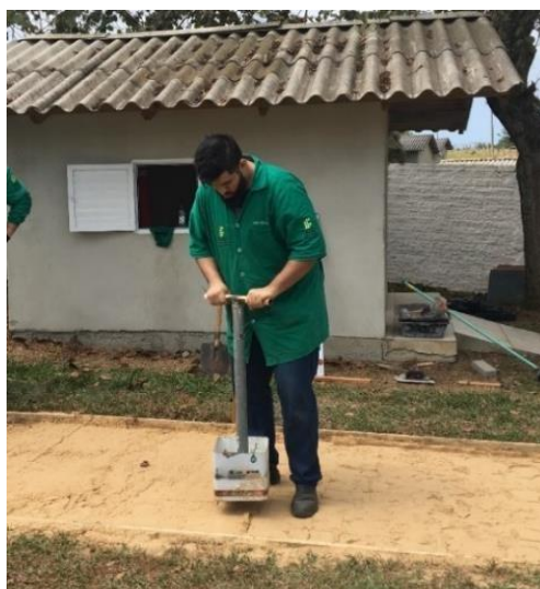
Figura 4 – Compactação das camadas de areia
