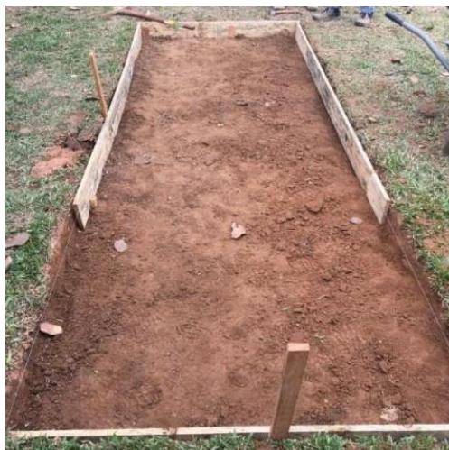
Figura 3 – Preparação da base e colocação das guias
