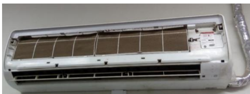
Figura 1 – Filtro sujo, obstruindo a passagem de ar
