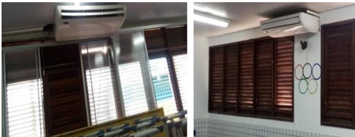
Figura 4 - Ar-condicionado funcionando em ambiente com vedação ambiente inadequada
