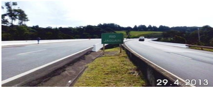
Figura 4: Ponte em estudo, sobre o rio Jaguari (Fonte: Andrade et al. , 2013)
