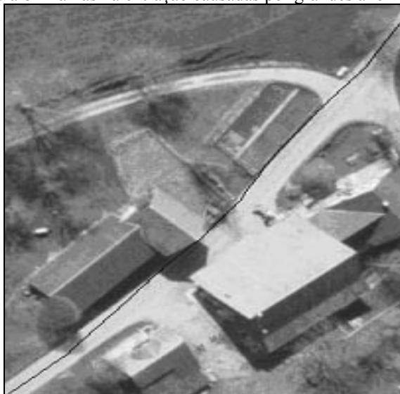
Figura 8 - Falhas na extração causadas por grandes anomalias.
