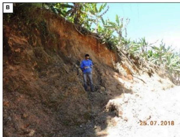
Figura 9: Escorregamentos associados a cortes de encostas. (A) Escorregamento translacional na localidade de Água Fria. (B) Escorregamento rotacional na localidade de Itacolomy. Fotos: Autores (A — 17/03/2018, B — 25/07/2018).
