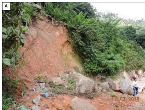
Figura 9: Escorregamentos associados a cortes de encostas. (A) Escorregamento translacional na localidade de Água Fria. (B) Escorregamento rotacional na localidade de Itacolomy. Fotos: Autores (A — 17/03/2018, B — 25/07/2018).
