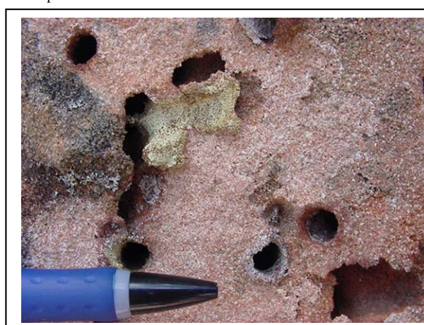
Figura 10: Incrustação de óxidos de ferro (vermelhas) e caulinita (claras) endurecendo perfurações no Arenito Vila Velha. Platô das Toquinhas, próximo ao Parque Estadual de Vila Velha.
