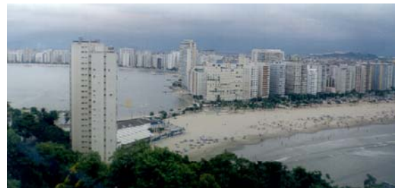
Figura 9: Tômbolo artificial da ilha Porchat (foto de 2001). Nota-se à direita a praia do Itararé, com faixa de areia larga, e à esquerda, a praia dos Milionários, com a presença dos espigões (Foto: Samara Cazzoli y Goya).
